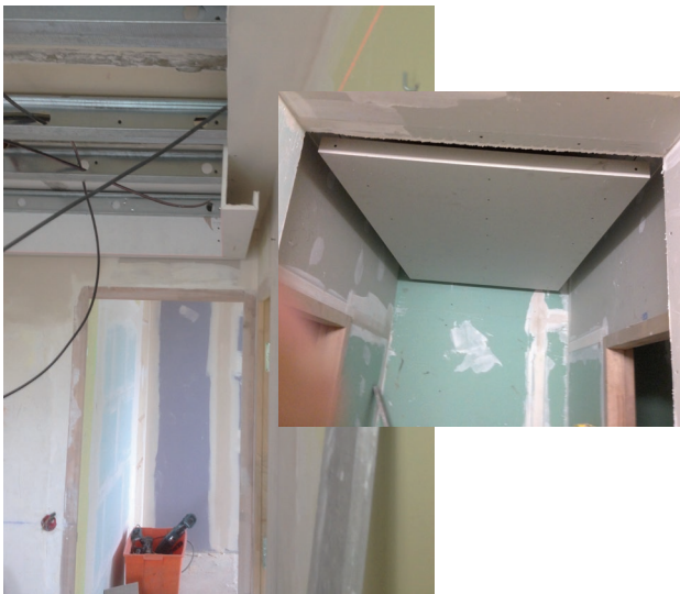
→ Plafond plaques de plâtre
